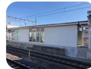
東武越生線駅施設
