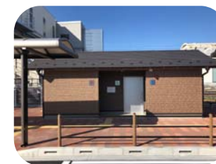
公衆トイレ外観
